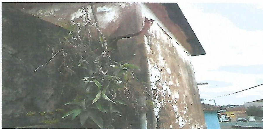
CAIXA D'AGUA, SEM USO, EXISTENTE NA AV. LIMÍRIO PEREIRA DE MELLO
